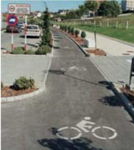
Imagen III. 4-1: Sendas-bici en paralelo al tráfico motorizado y peatonal y segregado de ambos (carriles-bici protegidos)
