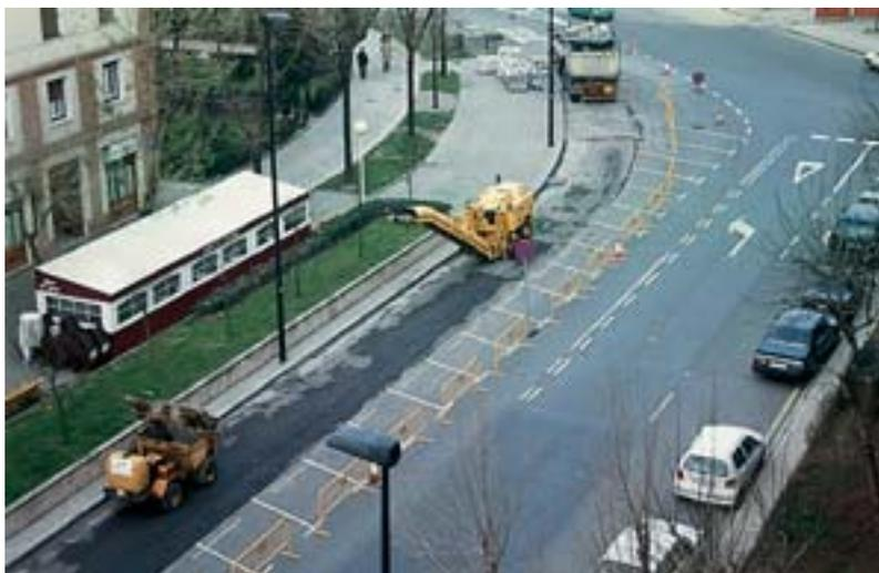
**Imagen II. 2-4: Senda-bici del tipo carril-bici protegido en construcción en Elorrieta (Bilbao)**
